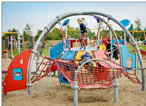
Les arches incurvées maintiennent le filet tendu sans attaches dérangeantes supplémentaires. Par conséquent, les arches sont fabriquées en acier inoxydable à haute température pour permettre au filet de se déplacer sur leur surface. La surface est traitée pour la rendre brillante.
