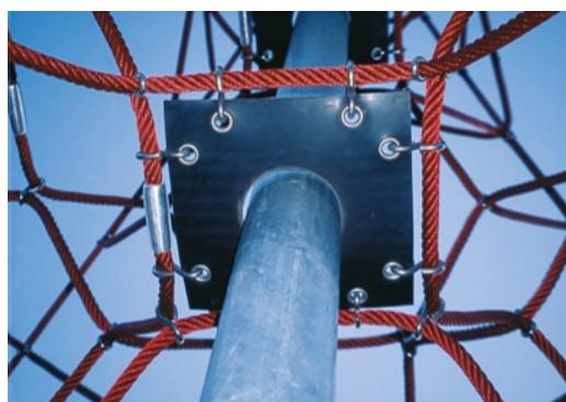
Membránky Corocord jsou vyrobeny z oděruvzdorného pogumovaného materiálu v kvalitě používané u pásových přepravníků a mají vynikající odolnost vůči UV záření. Jsou testovány a splňují nařízení REACH pro polycylické aromatické uhlvodíkyl (PAH). Je do nich integrováno čtyřvrstvé využití ze tkaného polyesteru. S tímto využitím a dvěma povrchovými vrstvami mají celkovou tloušťku 7,5 mm.
