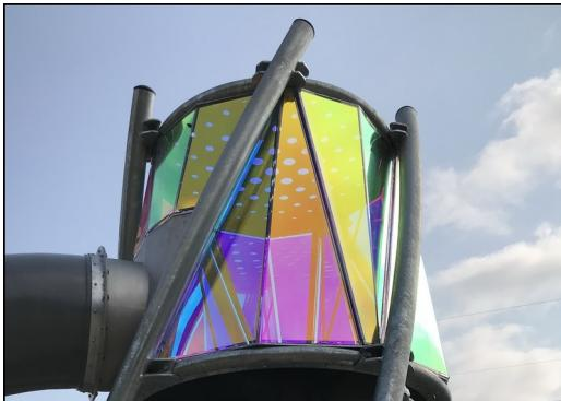
Grafické panely jsou vyrobeny z kvalitního polykarbonátu o tloušťce 6mm. Barevně měnící dichroický film je nalepen na vnější straně. PC panely jsou UV stabilizované, aby se zabránilo degradaci.
