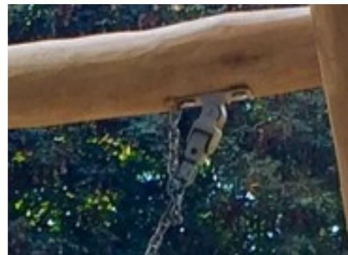
Les suspensions de balançoire pour les poutres transversales en bois Robinia sont constituées de fixations en acier inoxydable pouvant bouger selon deux axes. Les roulements à brides sont enrichis en silicone : la suspension ne nécessite donc pas d'entretien.
