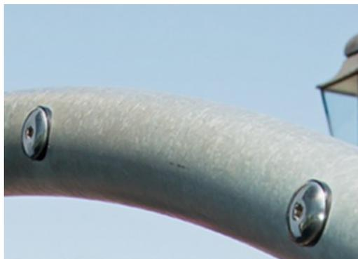
La struttura in acciaio è zincata a caldo all'interno e all'esterno con zinco senza piombo. La zincatura ha un'eccellente resistenza alla corrosione in ambienti esterni e richiede una bassa manutenzione.
