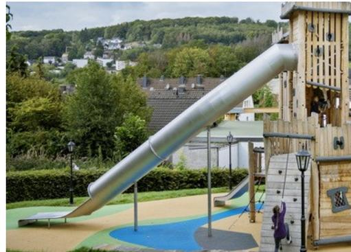
Los toboganes de túnel de acero inoxidable curvos y rectos están sostenidos por múltiples varillas de acero a un poste de acero central. Los toboganes del túnel están diseñados con una curva e inclinación perfectas para un paseo divertido.
