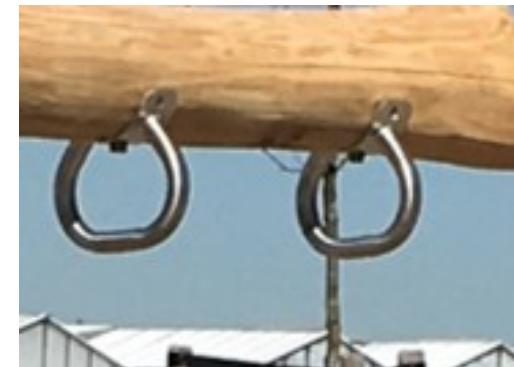
超过头顶高度的攀爬手柄由优质不锈钢制成。手柄通过不锈钢五金件固定在上面的 Robinia 原木横梁上。
