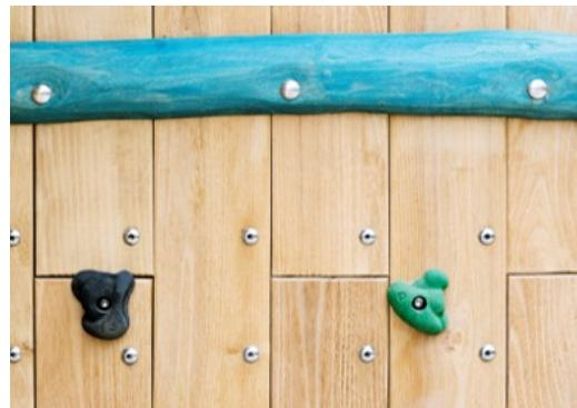
Kovové vybavení je vyrobeno z nerezové nebo pozinkované oceli pro zajištění trvalých spojů s vysokou odolností proti korozi.
