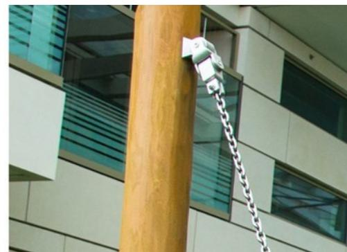
Le sospensioni a battente sono realizzate in poliammide e sono costituite da un doppio sistema di cuscinetti a sfera con snodo.
