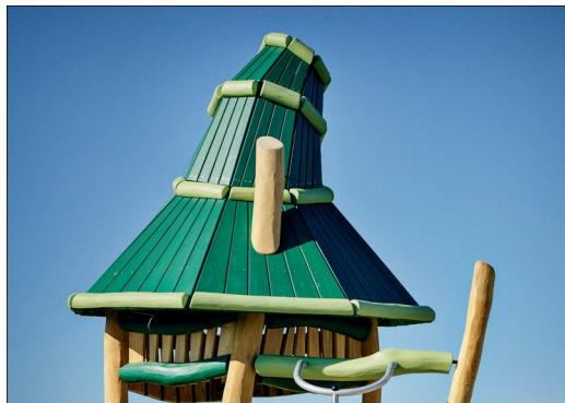
Barevné a pigmentované prvky jsou potaženy buď barvou na vodní bázi nebo transparentním hnědým pigmentem. Obě tyto varianty nátěru jsou v souladu s normou EN 71 část 3, jsou šetrné k životnímu prostředí a mají vynikající odolnost proti UV záření.
