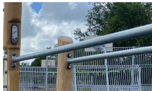
Le FSW209 dispose de trois barres push-up de 38 x 2 mm placées à trois hauteurs respectives de 38 cm, 58 cm et 133 cm.
