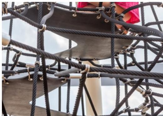
Membrány Corocord jsou vyrobeny z oděruvzdorného pogumovaného materiálu v kvalitě používané u pásových přepravníků a mají vynikající odolnost vůči UV záření. Jsou testovány a splňují nařízení REACH pro polycylické aromatické uhlovodík (PAH). Je do nich integrováno čtyřvrstvé vyztužení ze tkaného polyesteru. S tímto vyztužením a dvěma povrchovými vrstvami mají celkovou tloušťku 7,5 mm.
