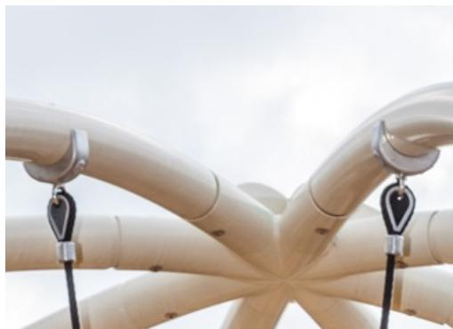
Hliníkové svorky Corocord slouží jako spojovací prvky mezi ocelovými sloupy a lanem. Hliníkový odlitek se zašroubuje do ocelového sloupu a bezpečně se připojí k lanu.
