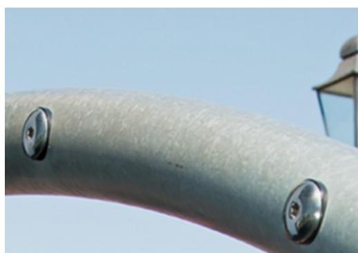
Ocelová konstrukce je žárově zinkována uvnitř i vně bez obsahu olova. Galvanizace má vynikající odolnost proti korozi ve venkovním prostředí a vyžaduje nízkou údržbu.
