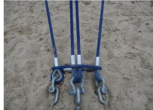
Die riesigen Raumnetzstrukturen werden im Fundament durch ein System von drei Spannschlössern gesichert. Horizontale und vertikale Kabel werden an die einzelnen Spannschlösser angebracht, welche mit den einzelnen Stahllankern verbunden sind. Dieses System sorgt dafür, dass jedes Kabel separat gespannt werden kann und erhöht die Tragsicherheit durch das unabhängige Verankern.
